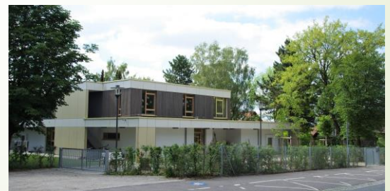
Regelkindergarten St, Barbara
